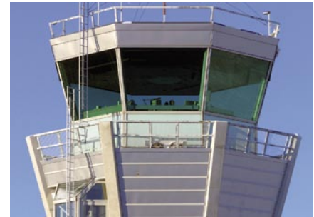
Kimmelix Oy:n Akusta-ääneneristyslaseissa käyttämä joustava hartsikerros eristää ääntä jopa 2 dB paremmin kuin perinteisillä menetelmillä valmistetut ääneneristyslasit.
