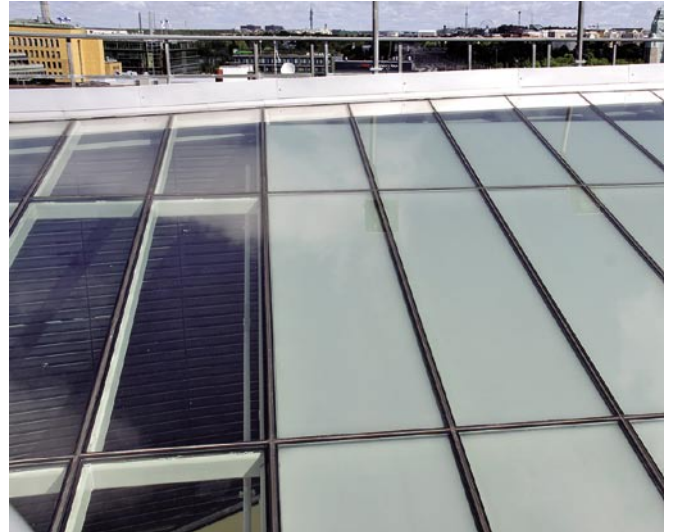
Valopihan lasikate, Stockmann Oyj, Helsinki. Lasitus on tehty 2k-eristyslasilla SG-lasitustyönä.
