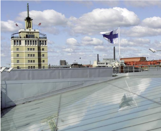
Valopihan lasikate, Stockmann Oyj, Helsinki. Lasitus on tehty 2k-eristyslasilla SG-lasitustyönä.
